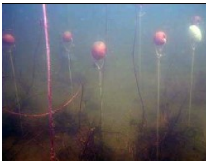
Immagine del cantiere subacqueo
